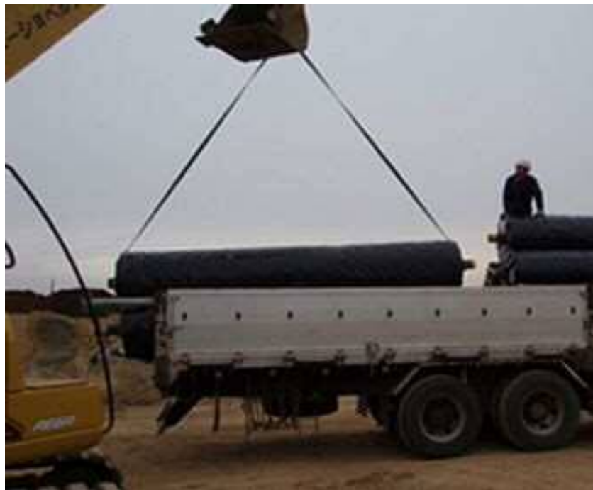
写真①-ナイロンスリングにて荷下ろし状況
