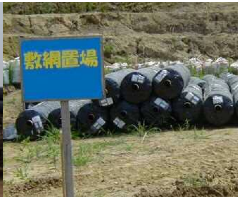
写真②-パラリンク置場
